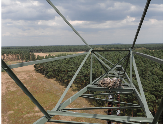
Baumfalkenhorst auf Traverse eines Hochspannungsmastes.
